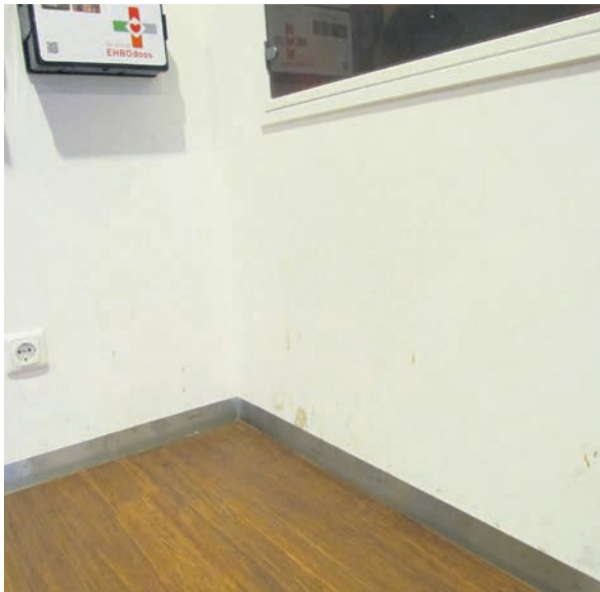
Onderhoud door vervuiling op druk bezochte plaatsen in gangen, trappenhallen, bij liften en pantry's bleek nodig
